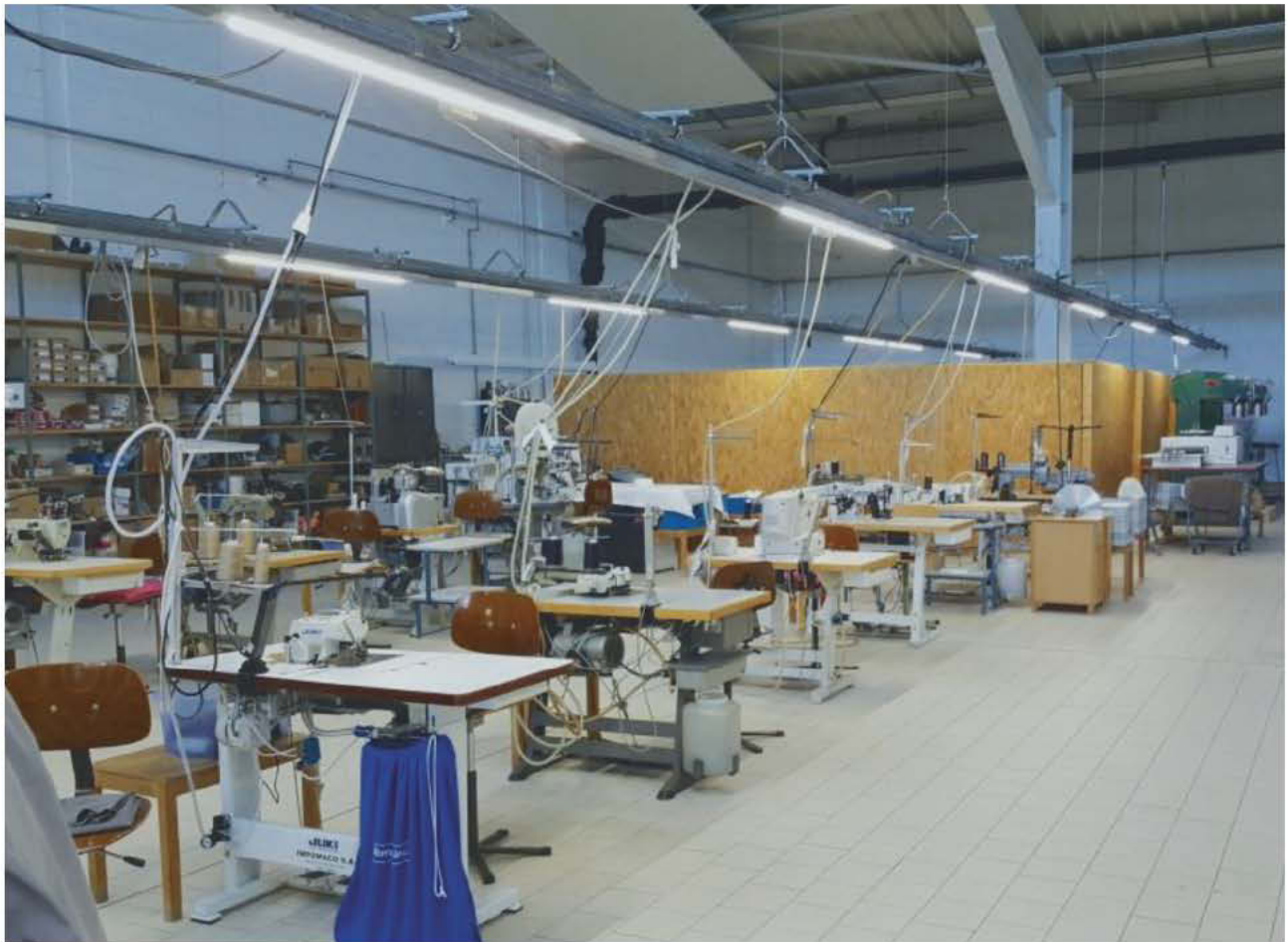
Fertigungshalle – wirtschaftliche Sanierung mit LED - Leuchtbandern
