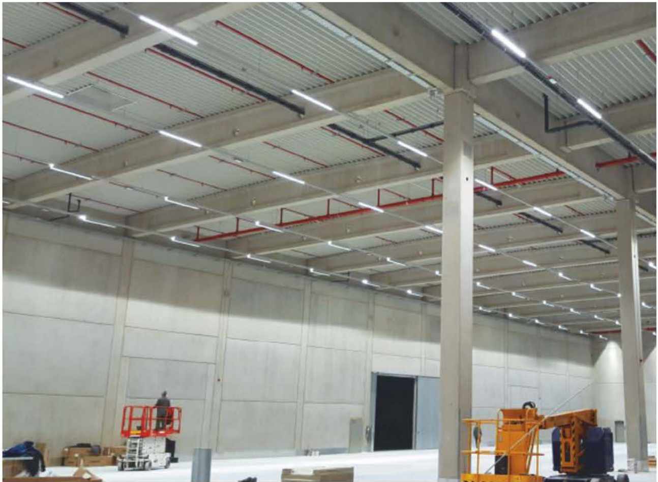
Logistikhalle mit Hochregalbeleuchtung
