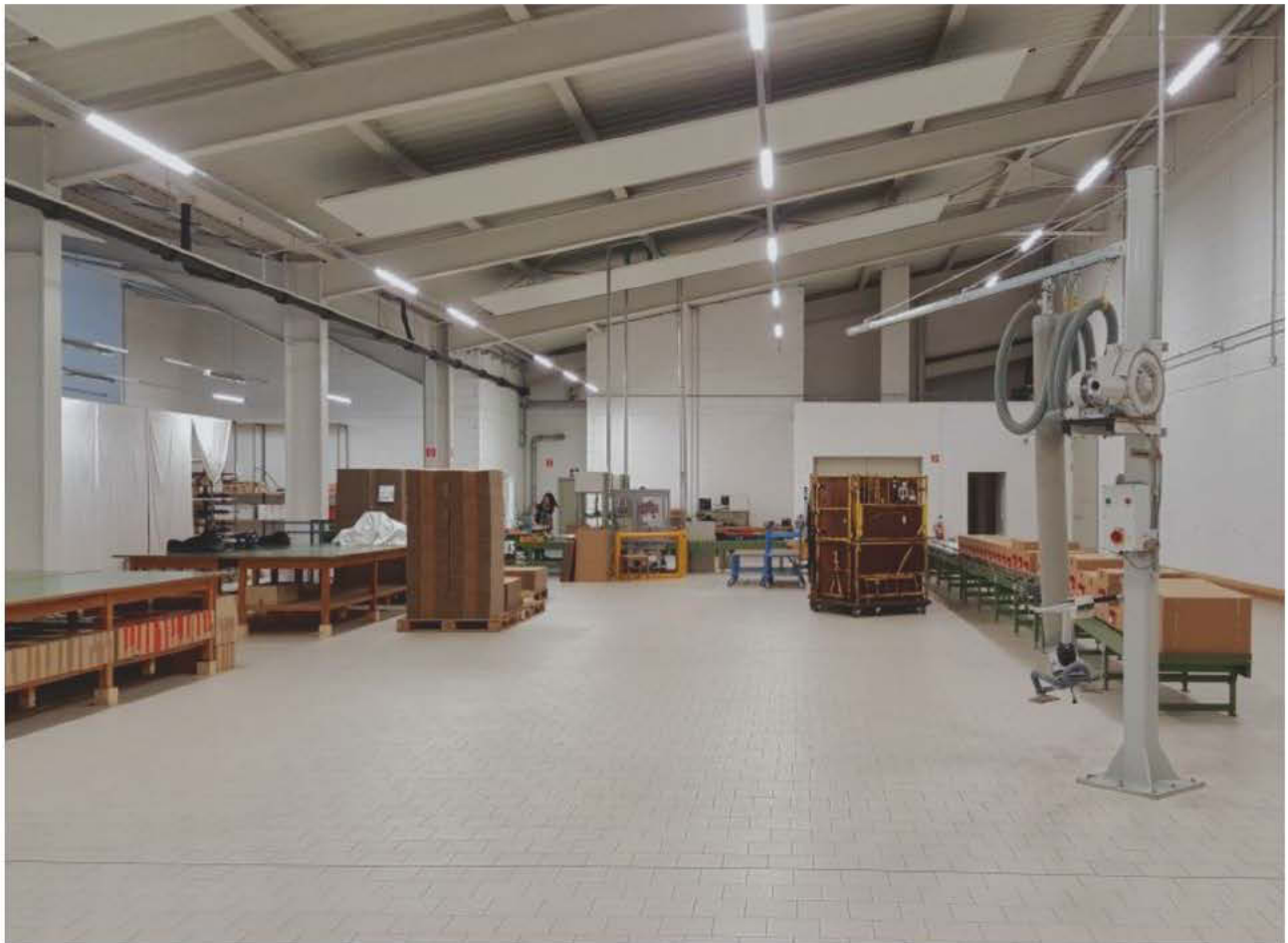
Lagerhalle – wirtschaftliche Sanierung mit LED - Leuchtbandern
