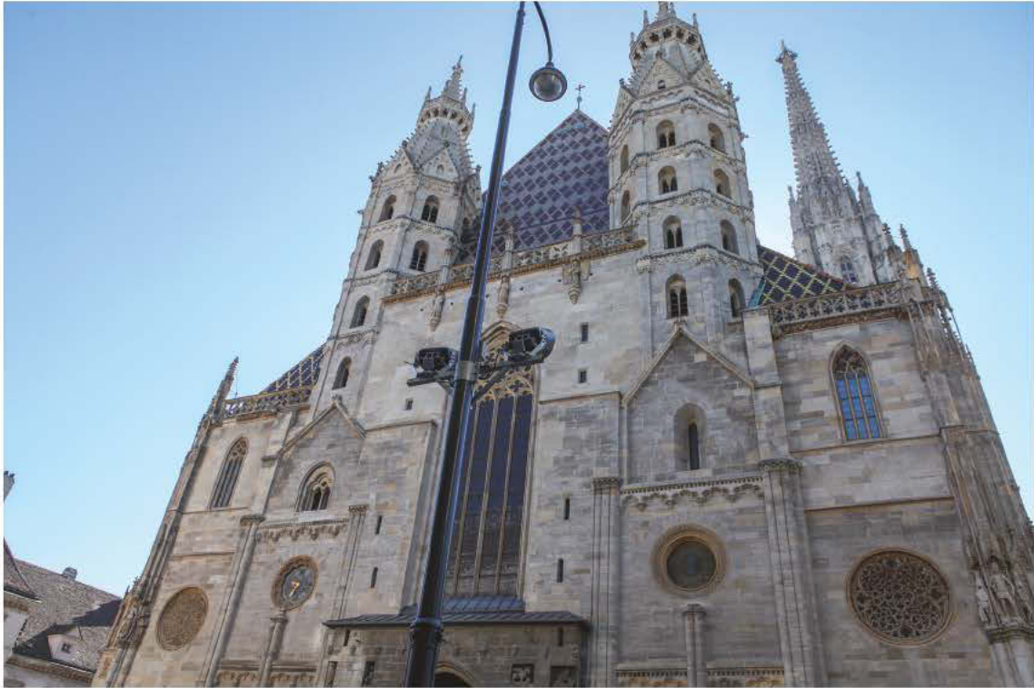
Frontportal mit Beleuchtungsmast - Tagesansicht
